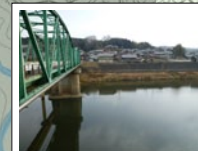
10 島ヶ原大橋より木津川川南方面を望む
