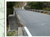
5 大和橋 追分から約400mのところにある。
