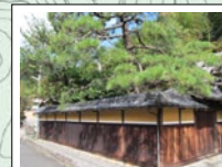
4 本陣跡 本陣・庄屋としての造りを伝える。表玄関横の庭には罪人を吟味する白洲があった。
