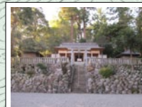
5 波瀬神社 菅原天神、天照皇大神、大山祇命などが祀られている。本殿裏には薬師堂と庚申祠がある。
