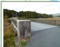
1 山田橋 山田川に架かる。この橋でいなべ市北勢町麻生田地内に入る。
