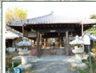
11 走井山勧学寺 十日観音として親しまれ、 本尊の千手観音は県指定文 化財。本堂は元禄時代の建 立。付近は中世末の矢田城跡 で、現在は走井山公園として 整備されている。伊勢西国 三十三所観音霊場第31番札 所
