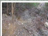
13 板木竈へ向かう崩れた街道 街道は、かつてバスが通っていたという小方峠越えの道の入口付近から沢沿いに登り、山を越えたあとは曲がりくねりながら下っていたという。現在は沢が崩れ、木が生い茂り、通行できない。
