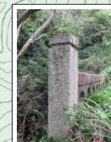
5 旧日向橋 現在の道の左側の低いところであり、草で覆われている。大正15年(1926)架橋。
