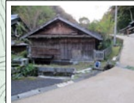
7 水路 街道脇を流れる水路。
