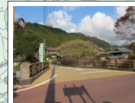
2 大橋 欄干を木製に復元。
