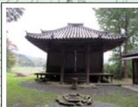
11 不動院 境内奥には不動滝がある。
