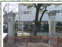
9 旧神戸中学校正門 旧神戸中学校が創立された 2年後の大正11年(1922)に 建立された。
