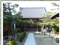
13 深正寺 参道の部分は、当時人家で埋められていた。
