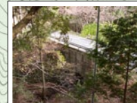
1 地藏谷橋 現在の天王橋。
