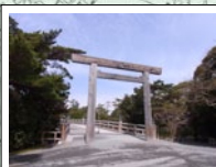
1 宇治橋 五十鈴川にかかる長さ約102mの総檜造りの橋。橋の両側に立つ二つの鳥居は、内宮・外宮の正殿の旧棟持柱で作られる。
