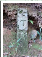
7 七丁目の町石 中ほどで折れ、接着して補修してある。
