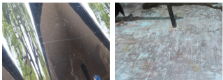
左、図3 | 【修復前】鏡面の損傷部分
