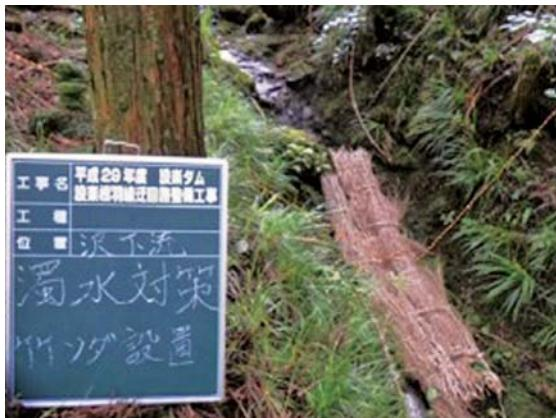
図19 粗朶（竹粗朶）。沈砂池と合わせて用いることで、濁水の土粒子を沈降させる効果を大きくすることができます（設楽ダム工事事務所提供）。
