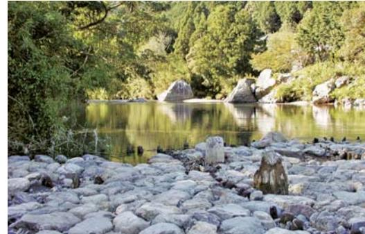
図18 天然石を敷き詰めた床止め工。橋脚周辺の床止めとして自然石を用いた例である。写真は、工事中のため露出しているが、再び水没すれば水生昆虫や稚魚のすみかとなると思われる（宮川水系 2003、奥が上流）。
