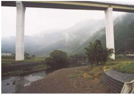
図 12 橋脚の位置の計画変更。ネコギギ等魚類への影響を軽減するため、橋脚の位置を調整し、なるべく河水に入らないように設計、施工した例である（宮川水系）。
