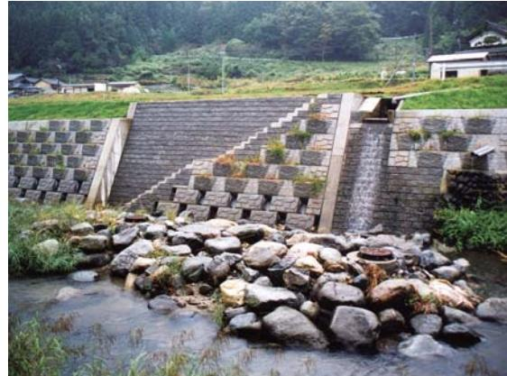
図15 凹凸のあるブロックと寄せ石。河川内に大石を配置し、護岸は魚類の隠れ家となるような凹凸のあるブロックを用いている（木津川水系2002、右が上流側）。
