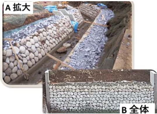
図 13 アンカー式空石積みの施行例（A拡大 B全体）。事前の生息状況調査において、ネコギギの生息が確認されたため、護岸の内部に複雑な空間をつくるため設置された。（宮川水系 2019, A右が上流側）。
