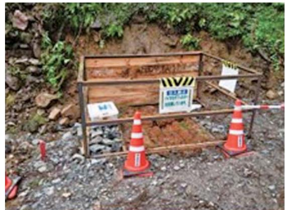
図20 フィルター材。沈砂池と合わせて用いることで、濁水の土粒子を沈降させる効果を大きくすることができます。また、現場条件から沈砂池の容量が十分に確保出来ない場合にフィルター材を用いることで、土砂の流出を抑制することができます（設楽ダム工事事務所提供）。
