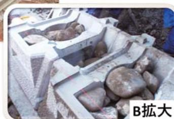
図14 ネコギギが利用できる魚巣ブロックの施工例（A全体 B拡大）。内部には、人頭大の玉石などを配置し、ネコギギが身を潜められるような空間を創出している（員弁川水系；いなべ市教育委員会提供）。
