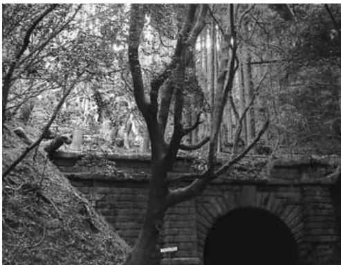
図5. 周辺の森林が伐採された廃隧道(津市)。
