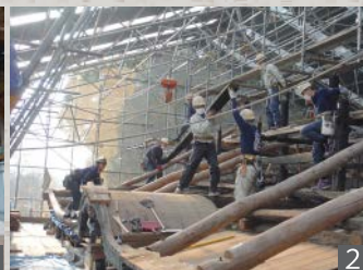
1 拝殿を覆屋で囲み、修理開始！ 2 3 4 屋根を外すと、垂木や梁などの構造材があらわとなりました。5 柱の見えない部分に馬の落書きを発見！江戸時代の大工さんの仕業のようです。ちょっとした発見に、場が和みます。
