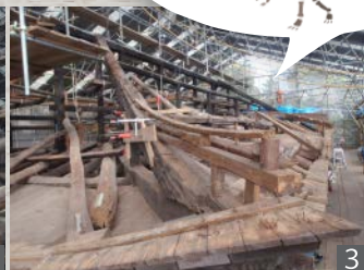
1 拝殿を覆屋で囲み、修理開始！ 2 3 4 屋根を外すと、垂木や梁などの構造材があらわとなりました。5 柱の見えない部分に馬の落書きを発見！江戸時代の大工さんの仕業のようです。ちょっとした発見に、場が和みます。
