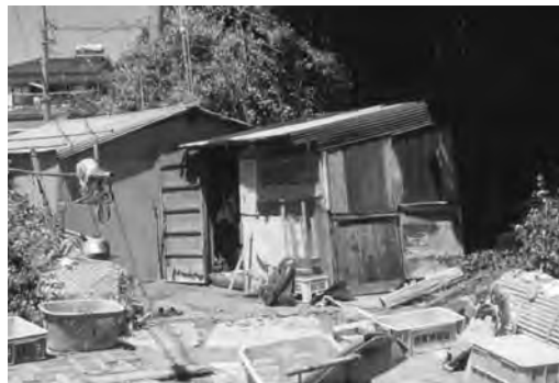
写真Ⅶ-3-19 海女3人で建てた海女小屋、右のトタンぶきの家
