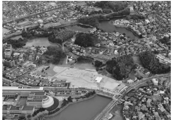
着工時の建設用地
