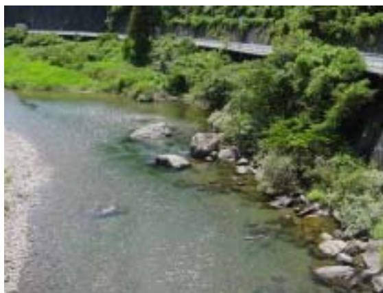
図9 コンクリート護岸基部の巨石や浮き石，寄せ石．道路の下側は人工護岸であるが，水際は巨石や浮き石が残っており（または寄せ石が設置されており），ネコギギの生息が確認された（宮川水系 2002，奥が上流側；鈴鹿水産研究室提供）。
