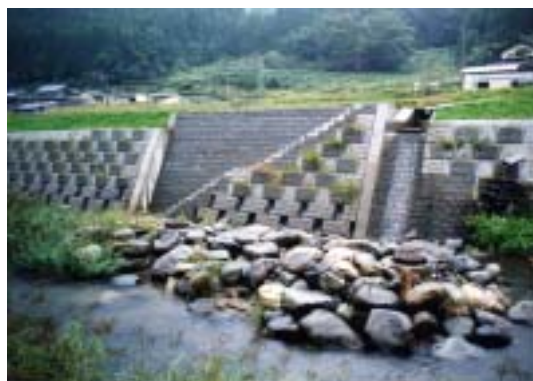
図13 凹凸のあるブロックと寄せ石。この事例はオオサンショウウオの生息に対して配慮が試みられた事例である。河川内に大石を配置し、マンホール型の繁殖用巣穴も設置されている。また、護岸は魚類の隠れ家となるような凹凸のあるブロックを用いている。この工事の検証は行われていないが、ブロック内の構造を複雑にし、水深の比較的深いところに施工すれば、ネコギギなどの魚類に対してもある程度の配慮効果を期待できる(木津川水系 2002, 右が上流側)。
