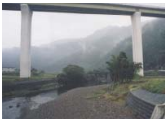
図 1 2 橋脚の位置の計画変更。ネコギギ等魚類への影響を軽減するため、橋脚の位置を調整し、なるべく河水に入らないように設計、施工した例である（宮川水系）。
