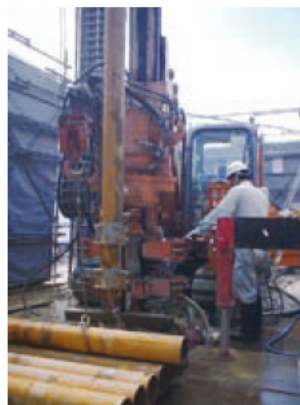
鋼管による掘削作業の様子
