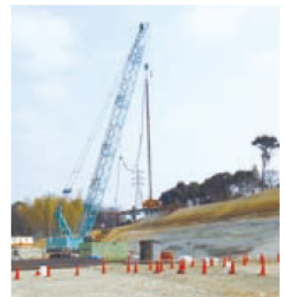
2月頃の工事の様子
