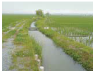
今も残る条里地割の素掘りの土水路
