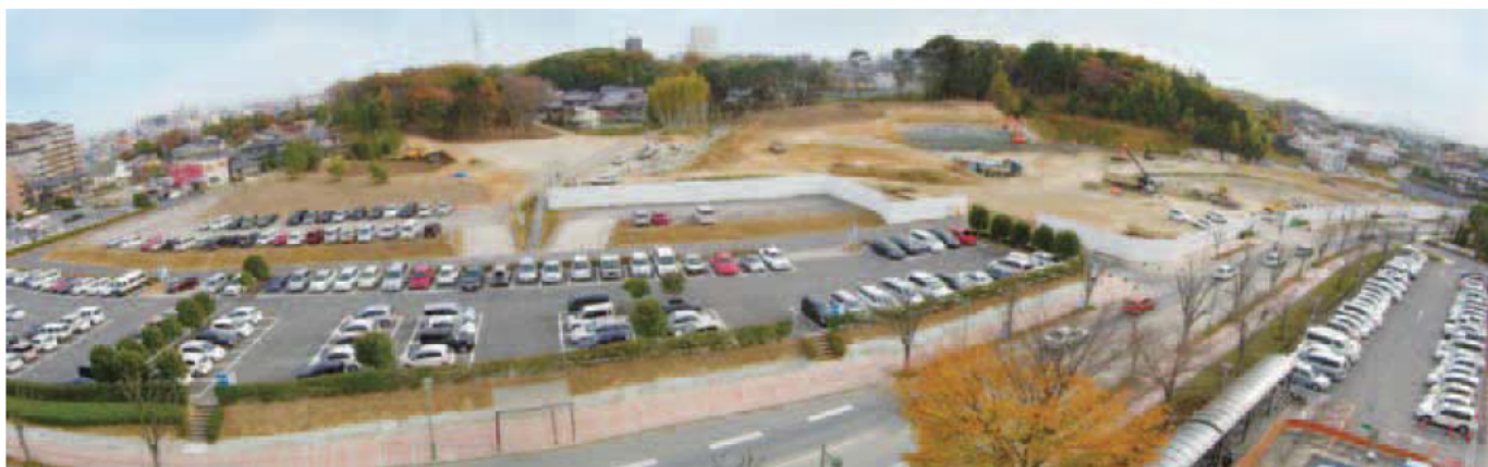
平成22(2010)年11月末の新博物館建設予定地の状況（造成工事中）
