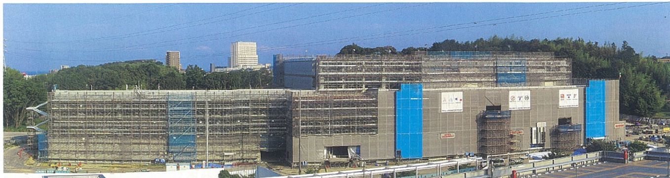
平成 24 年（2012 年）7 月上旬の建築工事の状況
