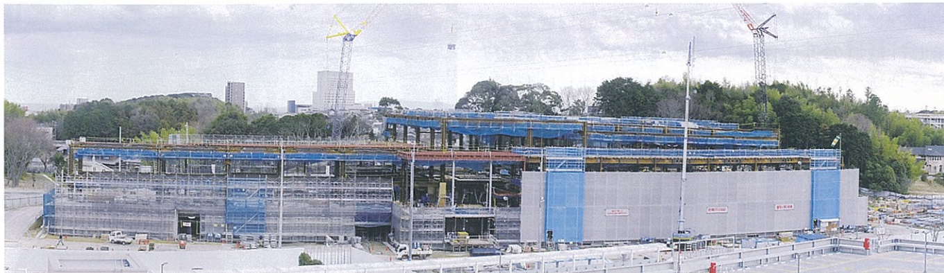
平成 24(2012)年3月上旬の建築工事の状況
