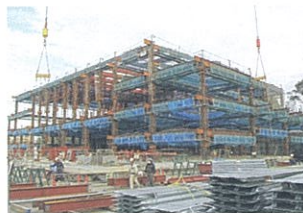
鉄骨建方の様子
