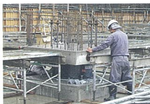
免震装置据え付けの様子
