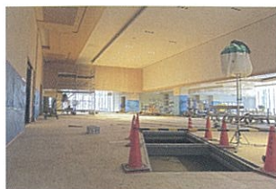
内装工事の様子
