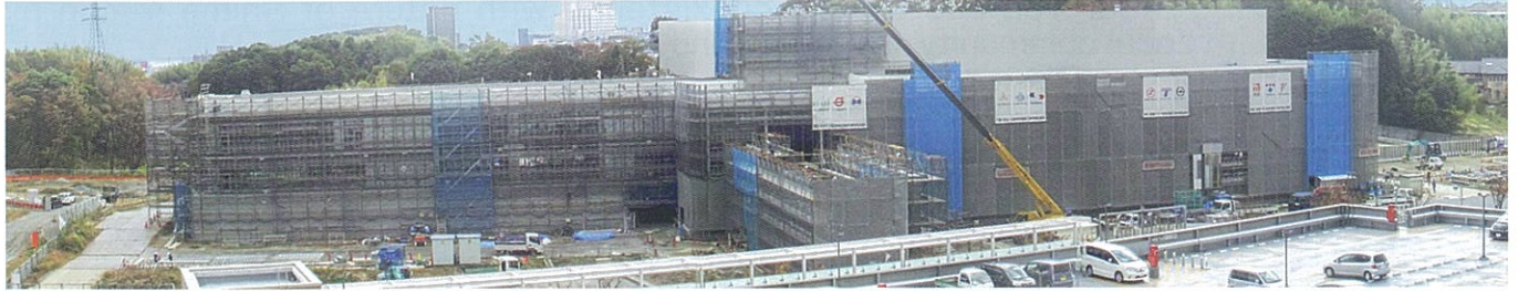
平成 24 年 11 月 20 日現在の建築工事の状況
