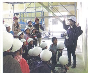
建設現場見学の様子
