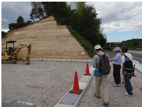
建設地周辺地質調査の様子
