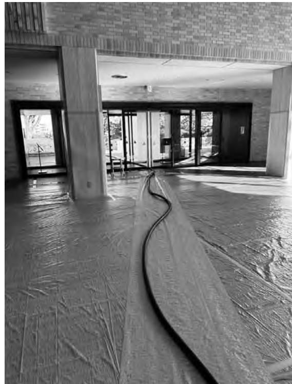
図13：作動油抜き取り作業時のビニール養生－エレベーターより
