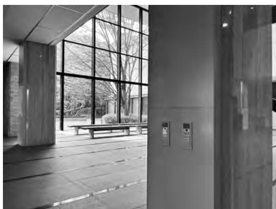
図4：エントランスホールに新設した防排煙システムの操作盤
