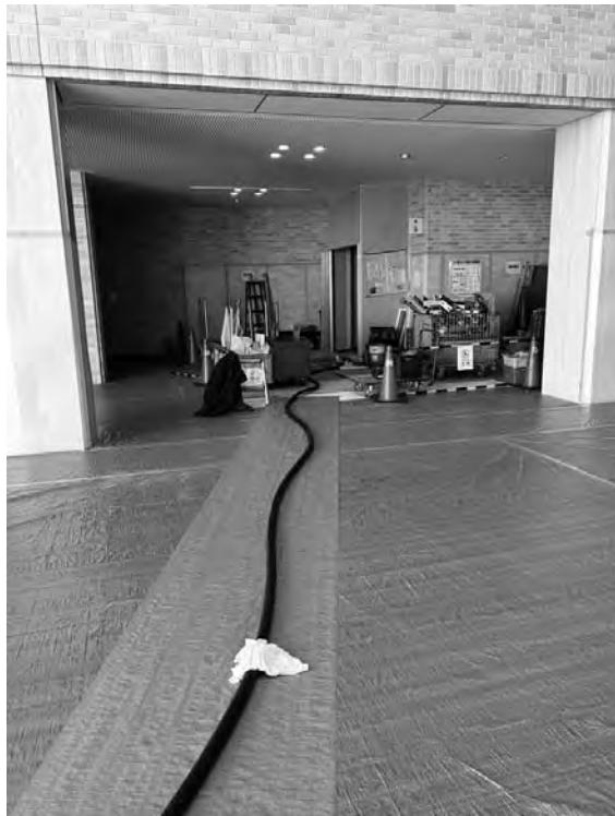
図12：作動油抜き取り作業時のビニール養生－正面玄関より
