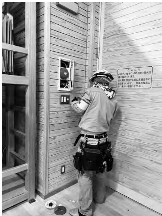
図2：収蔵庫内ガス消火設備操作盤改修
